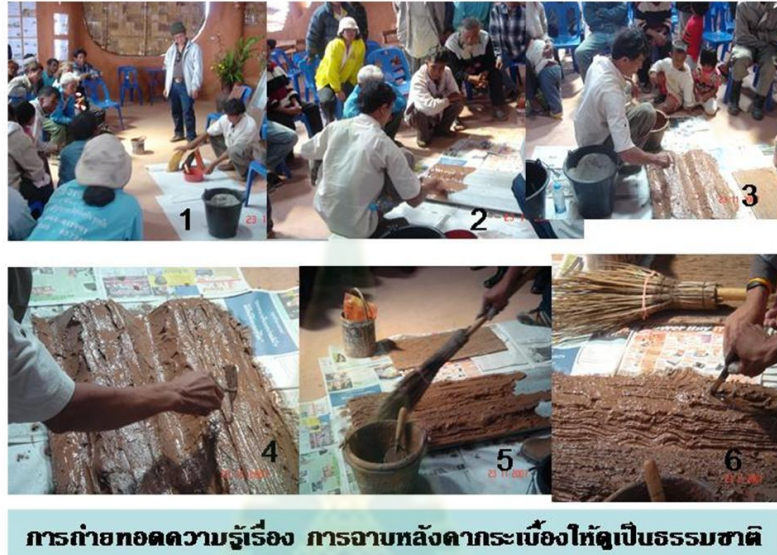
ภาพที่ 6.11 การถ่ายทอดความรู้เรื่อง การฉาบหลังคากระเบื้องให้ดูเป็นธรรมชาติ
